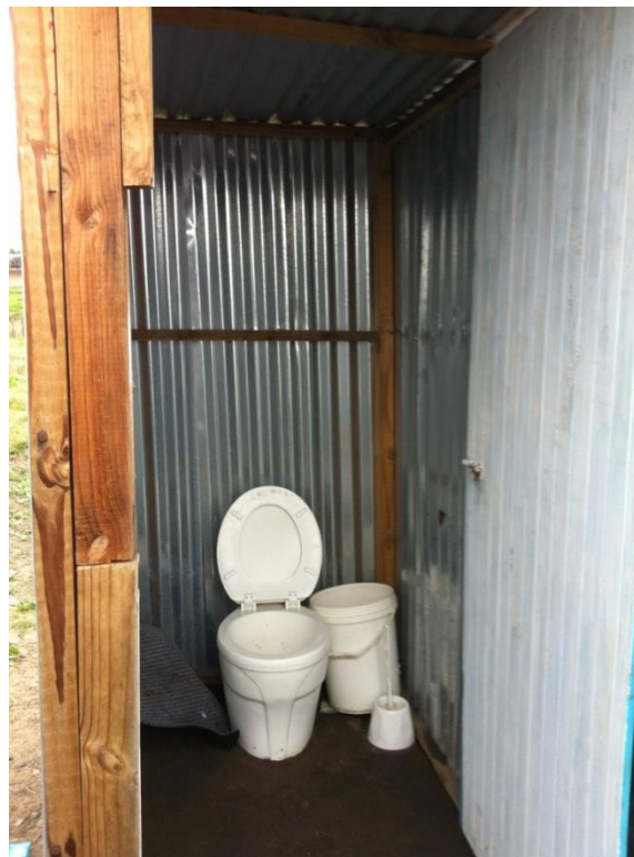
Figure I.1: Pour flush toilet in Klipheuwel (Pan 18/6/2014)
